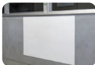
平滑壁面貼付例
